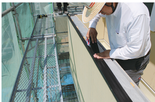
〔写真3〕防水テープを施工
