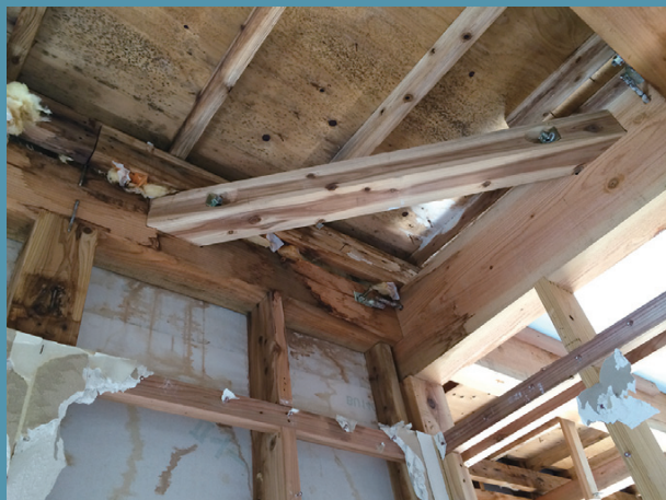
【写真10】築1年の2階建て木造住宅で起こった雨漏り。金属屋根で三方がパラペット納まり。パラペットの笠木の真上からくぎを打ち付けて下地となる木材に留めたため、くぎ穴から雨水が浸入（左上）。また、通気層の通気が不十分だったので壁内に湿気が充満。透湿防水シートと胴縁に染みが拡大し（右上）、木部でも腐朽が広がった（左下）。さらに屋根の水上側の雨押さえに換気口がなかったため、湿気が抜けず結露が発生。野地板が腐朽した（右下）（写真：ハウセコ）
