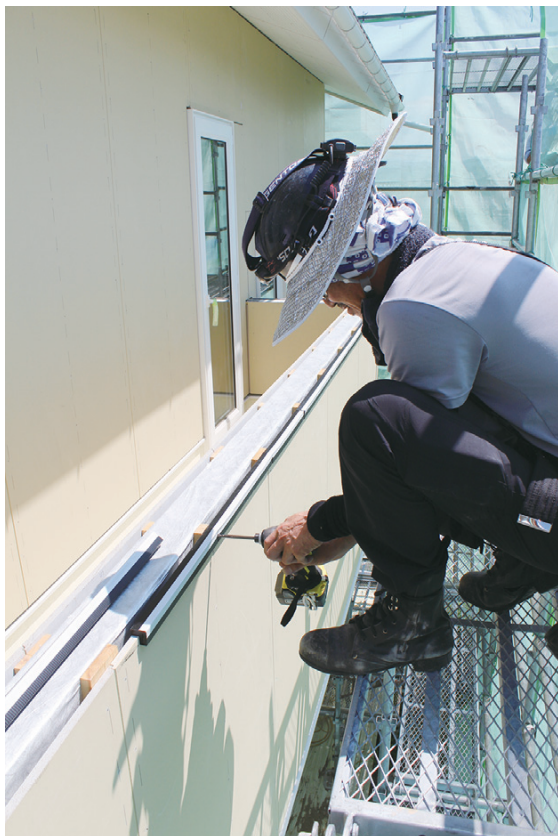
〔写真1〕外壁材の天端に換気部材を設置
