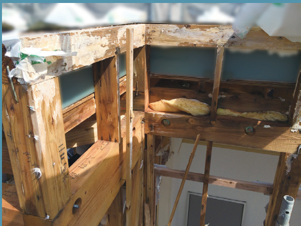
【写真10】築1年の2階建て木造住宅で起こった雨漏り。金属屋根で三方がパラペット納まり。パラペットの笠木の真上からくぎを打ち付けて下地となる木材に留めたため、くぎ穴から雨水が浸入（左上）。また、通気層の通気が不十分だったので壁内に湿気が充満。透湿防水シートと胴縁に染みが拡大し（右上）、木部でも腐朽が広がった（左下）。さらに屋根の水上側の雨押さえに換気口がなかったため、湿気が抜けず結露が発生。野地板が腐朽した（右下）（写真：ハウセコ）
