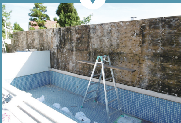
【写真1】延べ面積318m 2 の大規模な戸建て住宅で起こったトラブル。完成後わずか3ヵ月で、バルコニーの手すり壁やプールの塀で、水膨れやひび割れが多発した。仕上げ材と下地材を剥がすと、腐朽した合板が現れた。バルコニーもプールもほぼ同じ症状を示した（写真：39ページまで特記以外は本誌）
