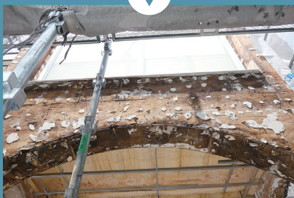
【写真1】延べ面積318m 2 の大規模な戸建て住宅で起こったトラブル。完成後わずか3ヵ月で、バルコニーの手すり壁やプールの塀で、水膨れやひび割れが多発した。仕上げ材と下地材を剥がすと、腐朽した合板が現れた。バルコニーもプールもほぼ同じ症状を示した（写真：39ページまで特記以外は本誌）
